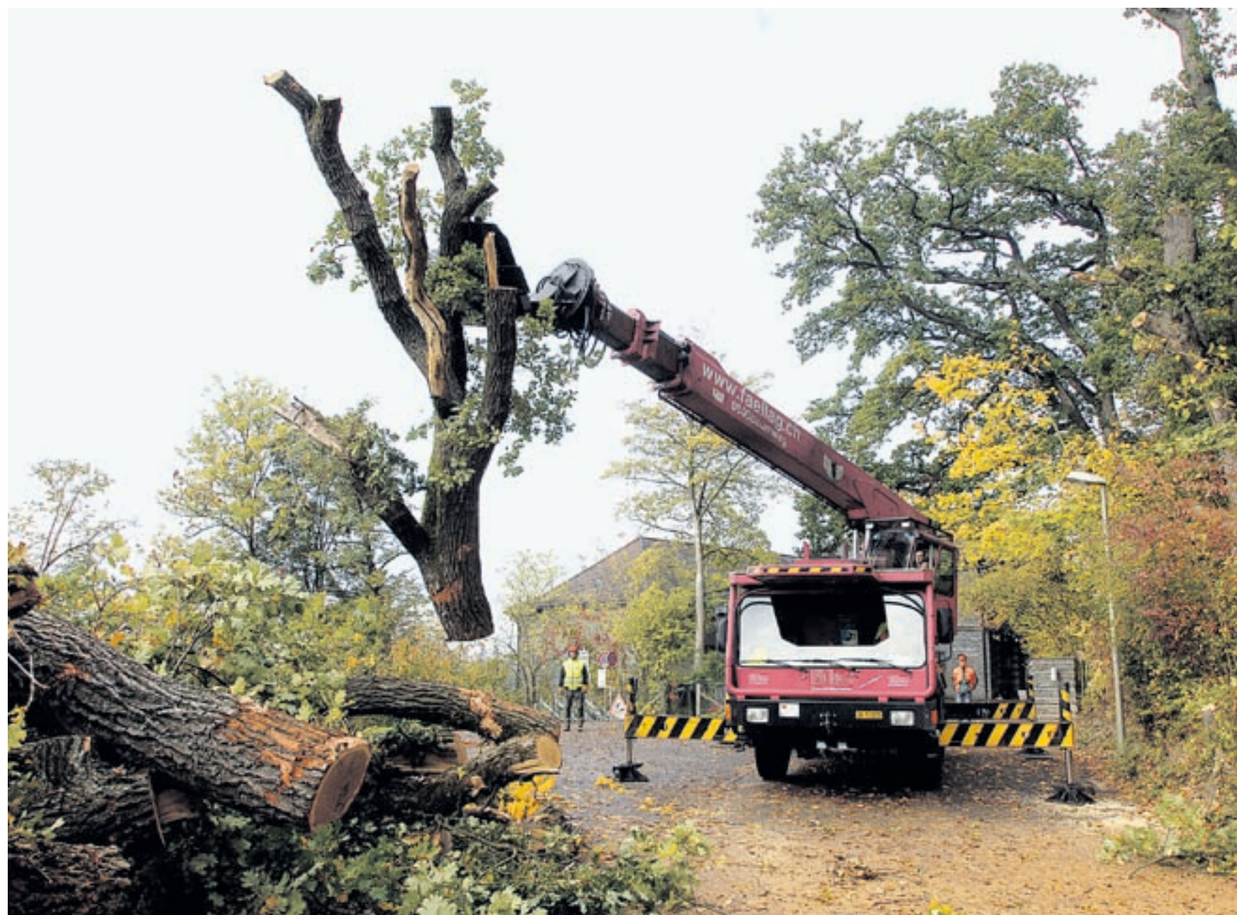
Mit dem Tree-Trimmer wurden gestern die Spitzen einiger Eichen auf dem Goldenberg abgesägt. Für die dicken Stämme war selbst diese Maschine zu klein. Bild: Peter Würmli
