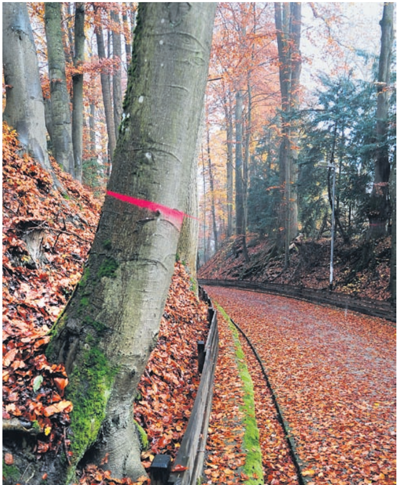
Bedrohtes Idyll: Bis zu 45 Bäume will die Stadt an der Turmhaldenstrasse fällen – aus Sicherheitsgründen. Bild: Marc Dahinden
